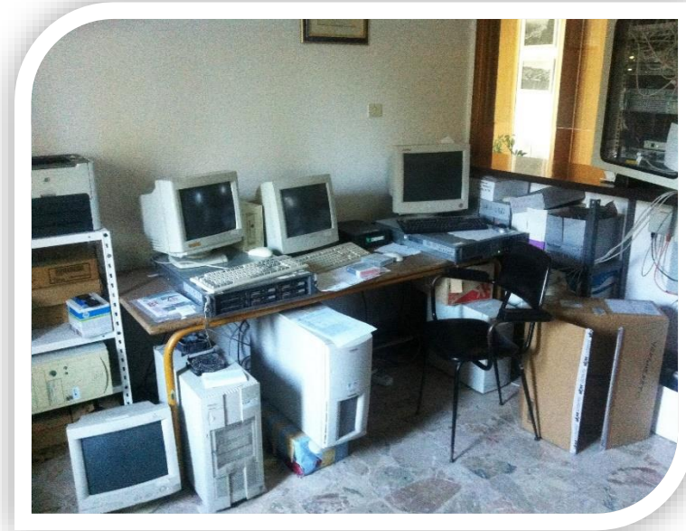
Data Center Verghereto
